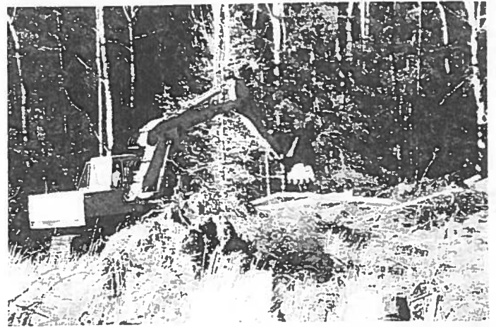
Abb. 5: Zur Flächenvorbereitung ist der Bagger ein vielseitig einsetzbares Gerät. Er kann Restholz verlagern. Boden zur Abdeckung entnehmen, Kalk und Dünger einarbeiten und Flächen vorsichtig planieren, ohne den Boden zu verdichten.
