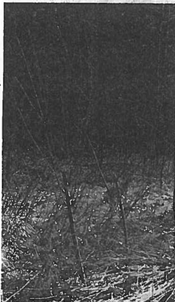
Links: Stärkere Weidenstangen sind mit einem soliden Hammer in den Boden zu treiben
