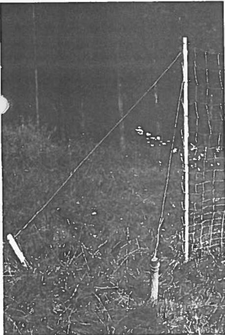
Bild 1: Rolle öffnen, Verbindungsplatte unten einlegen und Anfangspfosten setzen. Häringe bis handbreit unter Oberkante einschlagen. Ankerdrähte hinter Pfosten überkreuzen und an Häringen befestigen, dann Häringe bis zur Kerbe nachschlagen.
