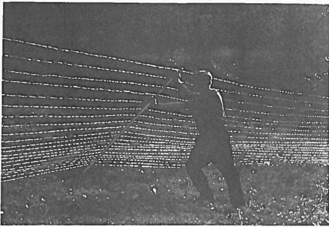
**Bild 5: Wenn keine gerade Front möglich** (im Altholz oder wegen schwierigen Geländes) wird die Spannung des Zaunes durch Herausdrücken der Zwischenpfosten aus der Front erzielt.
