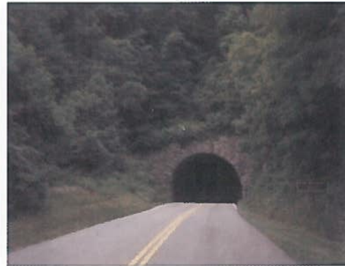
Figuur 4.9 Verkeerstunnel (Tucker, 1995)
