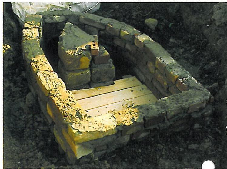
*Der fertige Kessel für den „Einröhrenbau“ – mit Holzpritsche auf dem Steinfußboden. Die Abdichtung erfolgt noch mit Eichenbohlen und Dachpappe*
