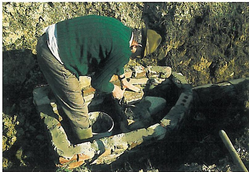
*Der Kessel für den „Einröhrenbau“ wird gemauert und der Fußboden mit Steinen ausgelegt (Materialbedarf insgesamt etwa 100 Verblender à 11,5 cm)*
