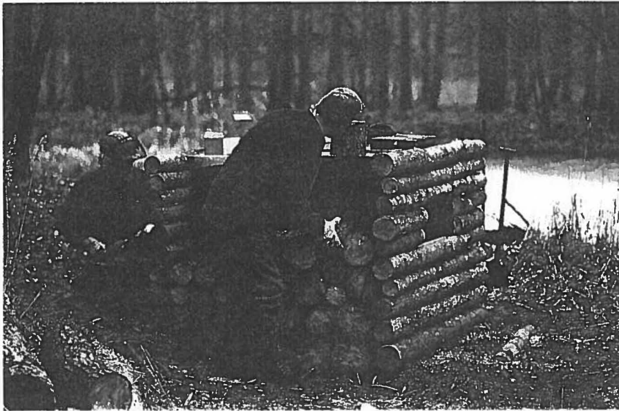
Sind Vor- und Rückseite verkleidet, werden die entstandenen „Seitenfächer“ mit etwa 45 Zentimeter langen Rundholzabschnitten aufgefüllt
