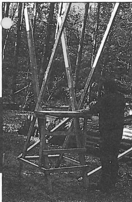
Zwei Winkel aus seitlich angenagelten Leisten bilden das Fundament für das Standbrett
