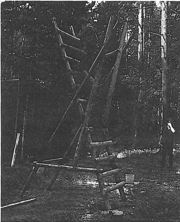
Im nächsten Arbeitsschritt werden die Rückenlehnen-Stützen befestigt
