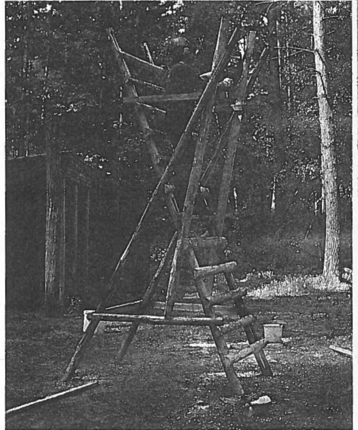
Um den Lehnenbrettern Halt zu geben, werden die Stützen oberhalb der Sitzdachlatten angeflacht
