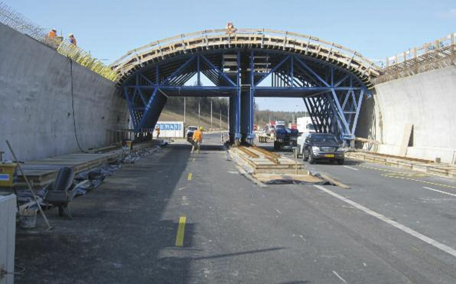
Ecoduct Hoog Buurlo in aanbouw
