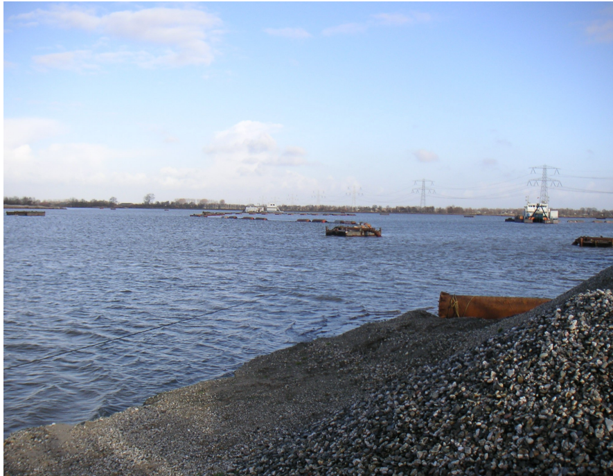
Foto 2 Met behulp van grote zuiginstallaties worden er grote hoeveelheden zand en grind van de bodem van dit meer omhoog gezogen.
