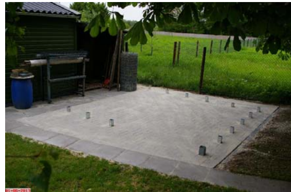
De vloer is al gelegd
