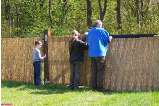
Rietmatten worden geplaatst
