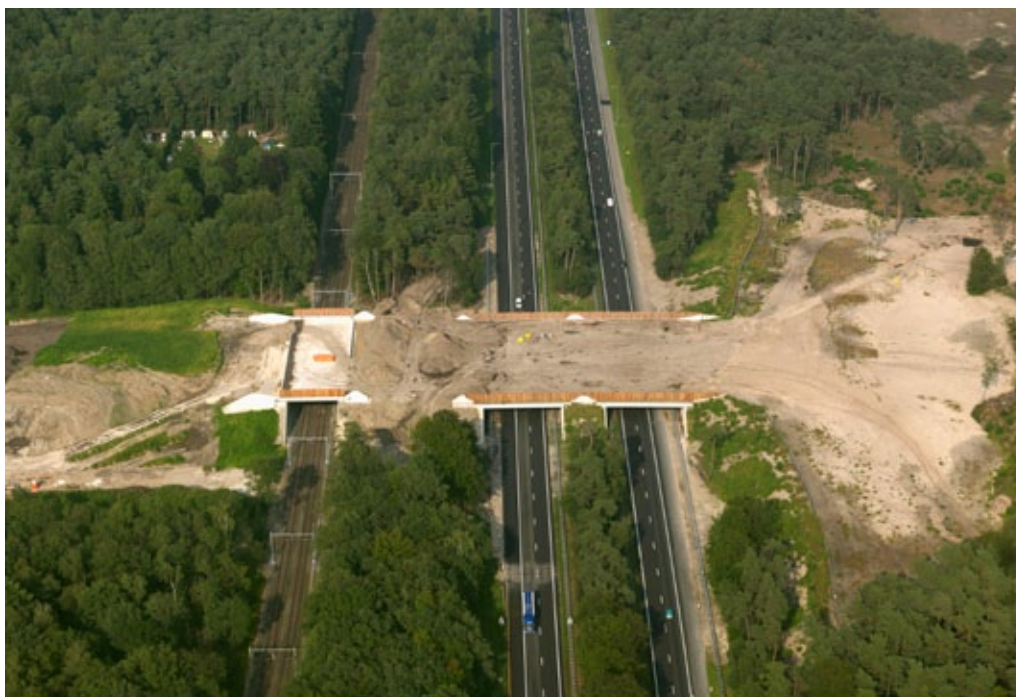
Figuur 3.1 Aanleg ecoduct Hulshorst over bestaande weg en spoorweg (foto: Combinatie H 2 Eco).
