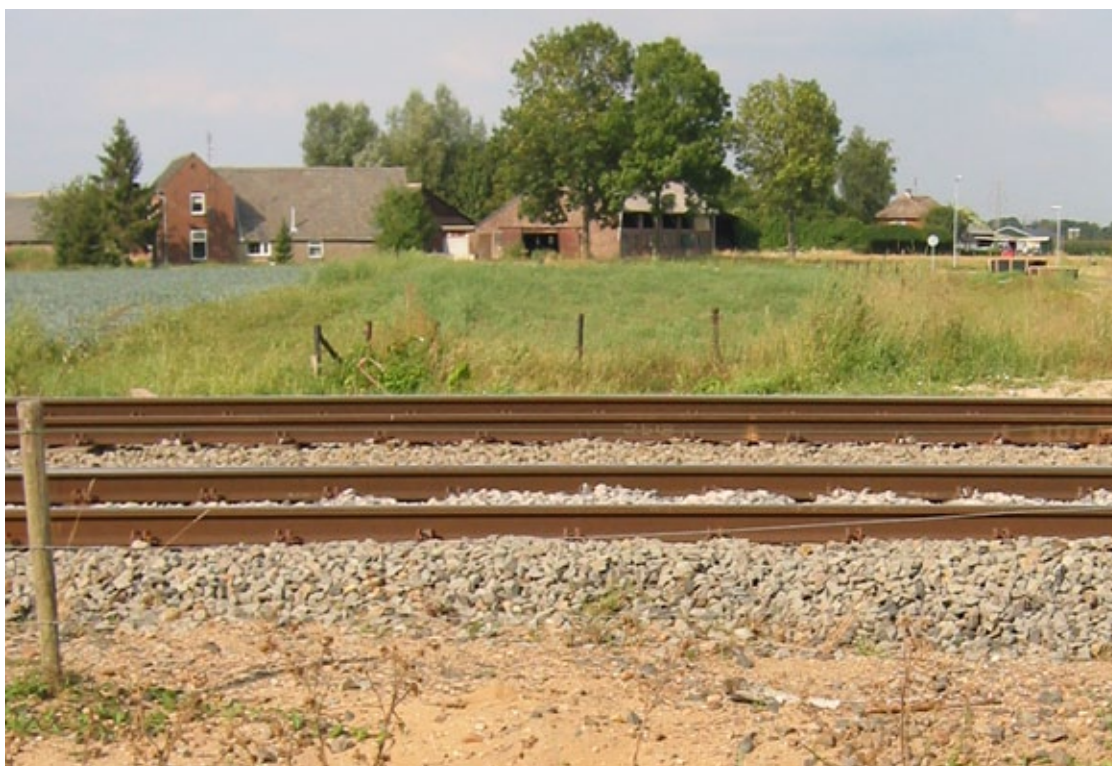
Figuur 4.3 Het grindbed en de rails vormen voor kleine dieren al een onoverkomelijke barrière. (Foto: ProRail).
