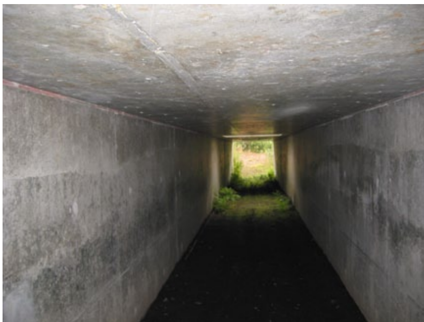
Figuur 2.2 Veel diersoorten gebruiken tunnels onder (spoor)wegen, maar ze stellen eisen aan de vorm en de afmetingen. Voor veel soorten geldt 'hoe langer de tunnel, hoe breder en hoger die moet zijn'. Maar soms dwingen lokale omstandigheden tot afwijken van standaardregels. Bij deze lange tunnel was het niet mogelijk om hem hoog te maken. Als oplossing is halverwege een gat gemaakt, waardoor hij minder donker is en minder lang lijkt. Hij wordt daardoor, ondanks zijn lengte toch gebruikt door reeën en wilde zwijnen.
