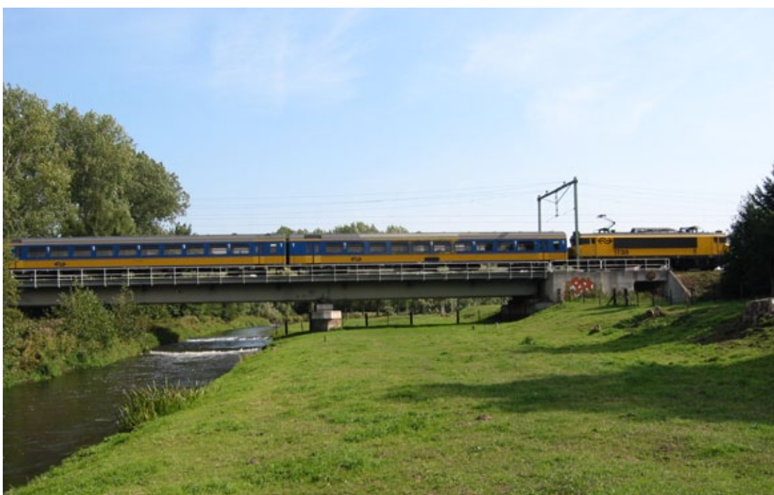
Figuur 4.5 Als een (spoor)weg een waterloop kruist, kunnen de oevers onder de brug functioneren als faunapassage (Foto: ProRail).
