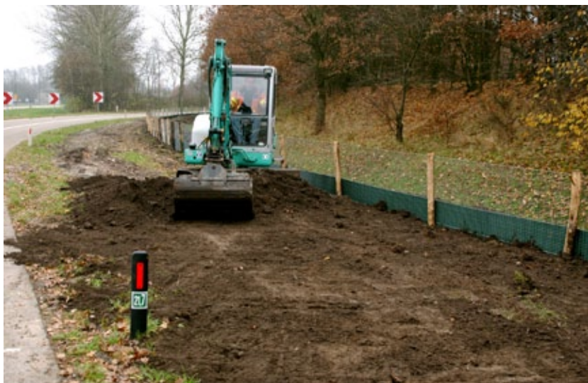
Figuur 4.15 Aanleg rasters en amfibieschermen (foto: Arfman).
