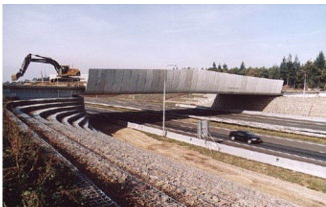
Figuur 4.16 - 4.19 Aanleg van ecoduct de Borkeld (A1), onderste foto: het met schanskorven opgebouwde talud.
