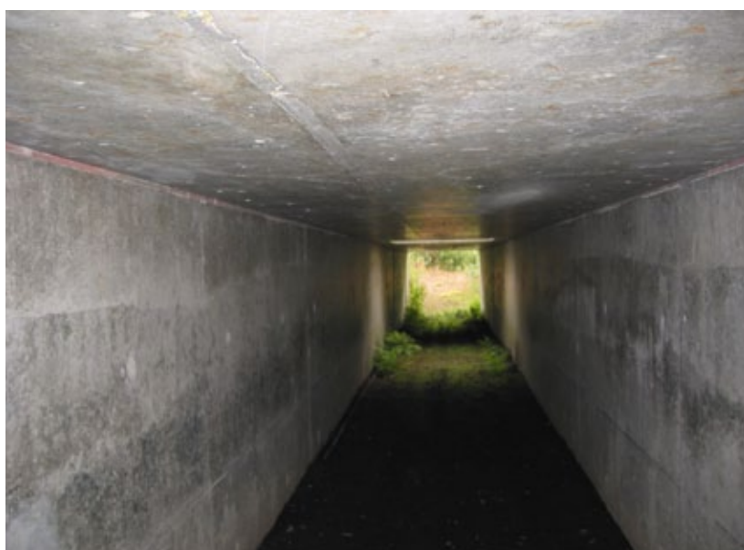
Figuur 4.8 Veel diersoorten gebruiken tunnels onder infrastructuur, maar ze stellen eisen aan de vorm en de afmetingen. Voor veel soorten geldt 'hoe langer de tunnel, hoe breder en hoger die moet zijn'. De tunnel op de foto heeft halverwege een gat. Hierdoor is het minder donker en lijkt de tunnel minder lang. Hij is daardoor, ondanks zijn lengte toch geschikt voor reeën en wilde zwijnen. (Foto: ProRail).
