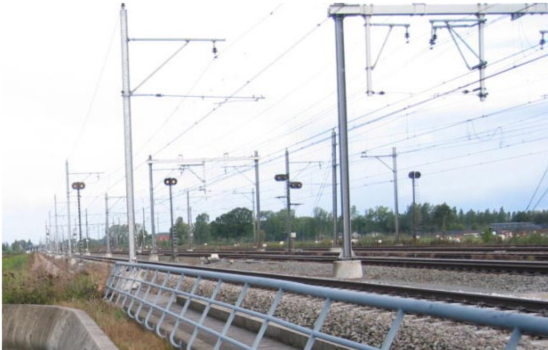
Figuur 4.4 Door alle draden van de bovenleiding ligt een onderdoorgang hier meer voor de hand, dan een verbindingroute overlangs (Foto: ProRail).
